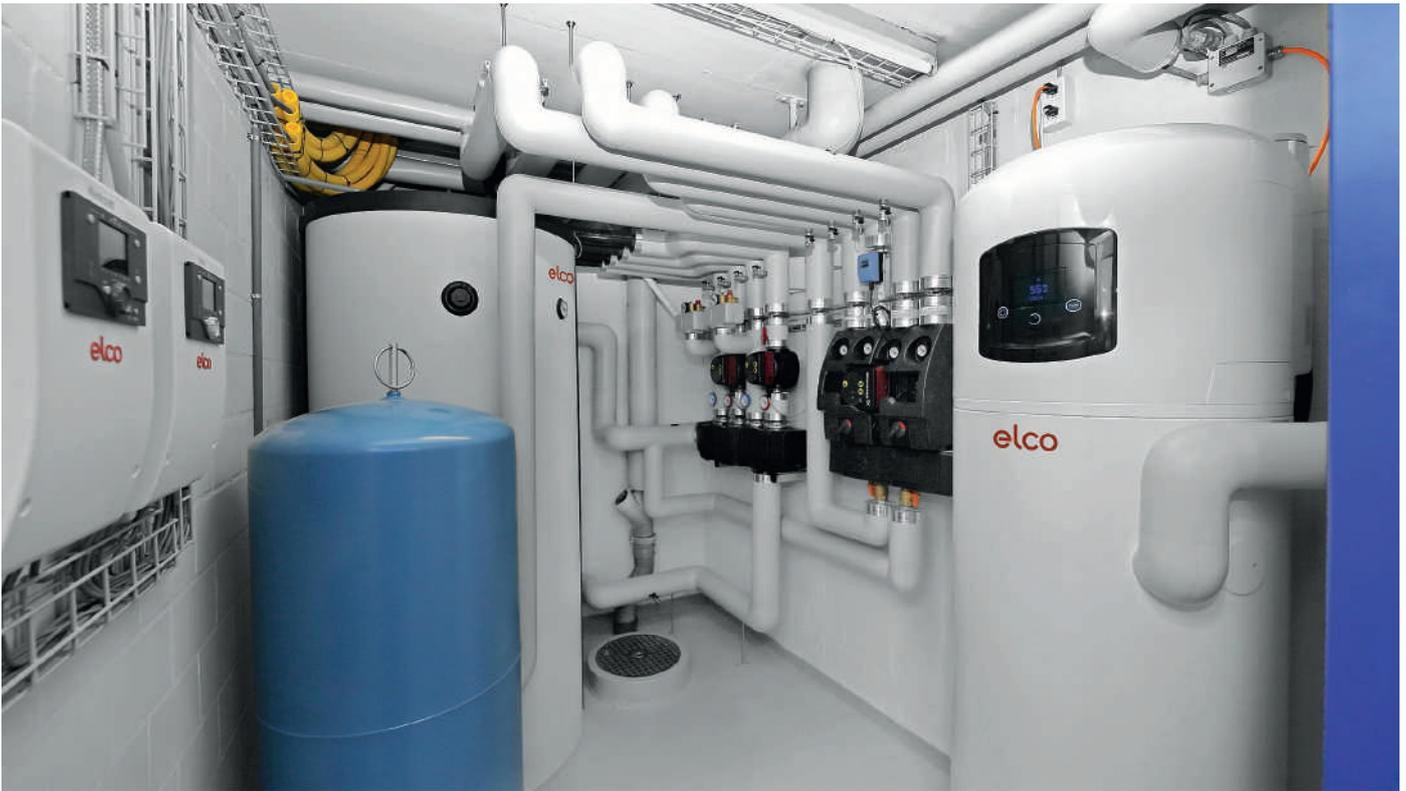
Blick in den Technikraum mit Warmwasser-Wärmepumpe Aerotop DHW (rechts) und technischem Heizspeicher Vistron B 1000 Liter.
