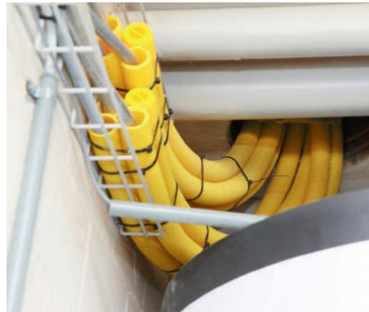
**Kamin und Zuluftkanal der alten Ölheizung wurden für die Verlegung der Elektrokabel bzw. des Vor- und Rücklaufs der Wärmepumpe genutzt.**
